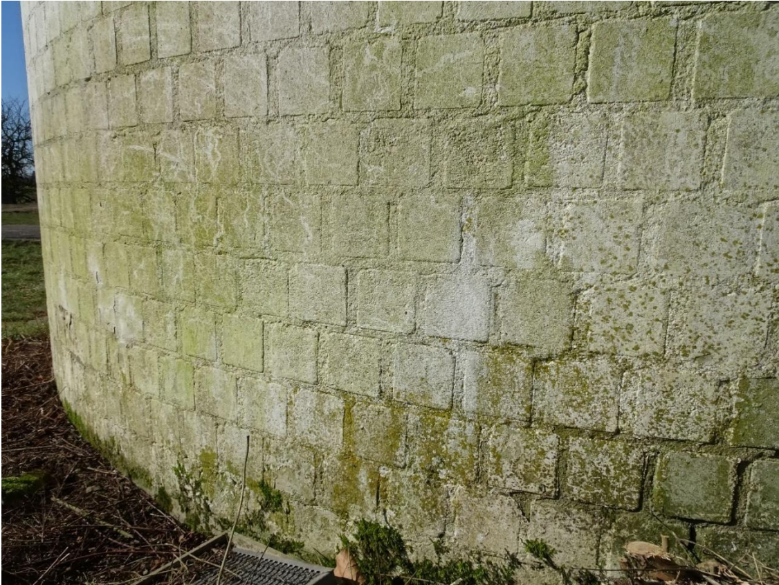
Hauptgebäude (Rundbau mit Kuppel)
